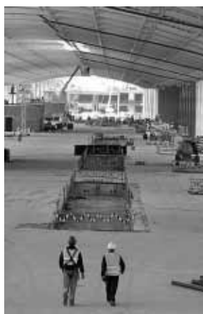
Obras de la T-Sur
